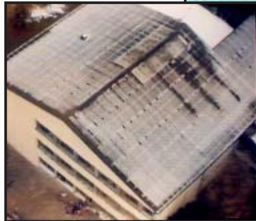
Die markante Erwärmung im Dachbereich dieses Schulgebäudes zeigt eine schlechte Wärmedämmung der obersten Geschosßdecke. Die höhere Oberflächentemperatur bringt an dieser Stelle den Schnee zum Schmelzen.
